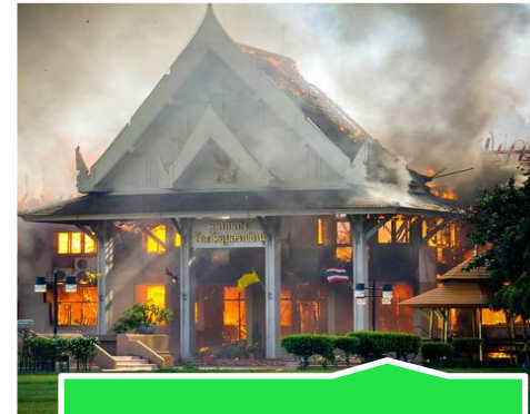
เพลิงไหม้
